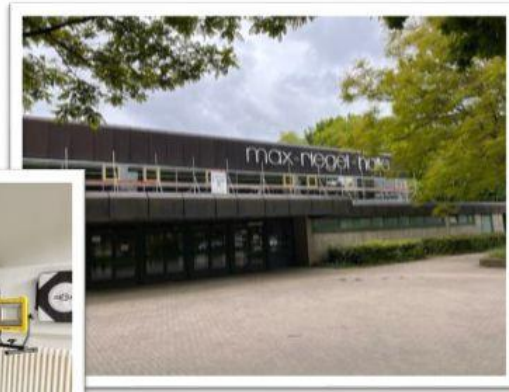
Die Max-Riegel-Halle in Teilsanierung
